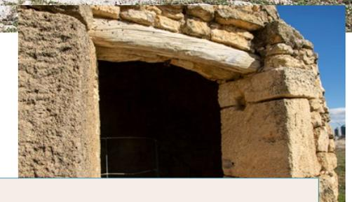
➡ A diferencia de otras neveras, no se colocó un gran dintel de piedra sobre la puerta, sino que se solucionó mediante el uso de maderos.
