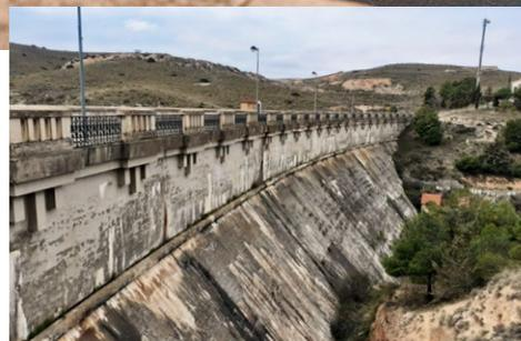
La masa de agua que represa el embalse de Moneva, linda con los términos municipales de Samper del Salz, Azuara y Moneva. Ocupa una extensión de **75 hectáreas de superficie y 8 hectómetros cúbicos de volumen**. La presa está construida por gravedad, tiene una planta curva con un radio de 152 metros, su altura sobre el cauce es de 33 metros y su cota máxima son 614,67 metros sobre el nivel del mar.
